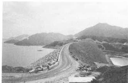
西大壩是世界上最高的瀝青混凝土心結構大壩，而東大壩建成後還要高出二十英尺。
