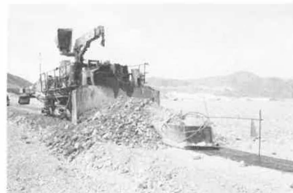
鋪設瀝青混凝土壩心。
