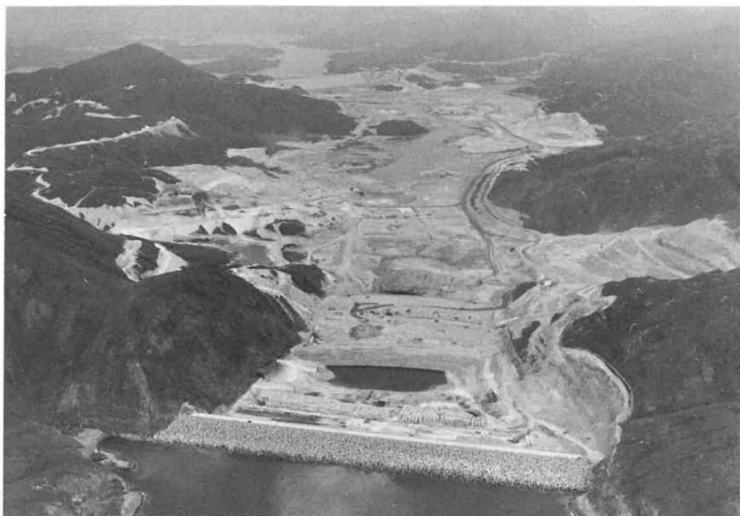
船灣淡水湖工程鳥瞰圖，攝於一九七七年初。左邊是糧船灣洲，右邊是西貢半島。前景是東壩外的防波堰，後面就是在興建中的東大壩。背景是幾近建成的東大壩。
