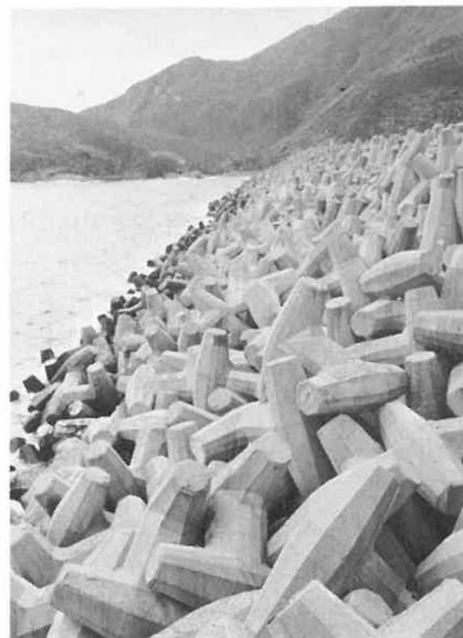
七千個立體交錯「工」字型混凝土「疊牢石」構成一道堅固的防波堤，保護東大壩免受海浪衝擊。
